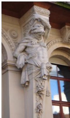
Balkonstütze in skulpturaler Ausführung (Photo: Prinz-Max-Palais, KA)
