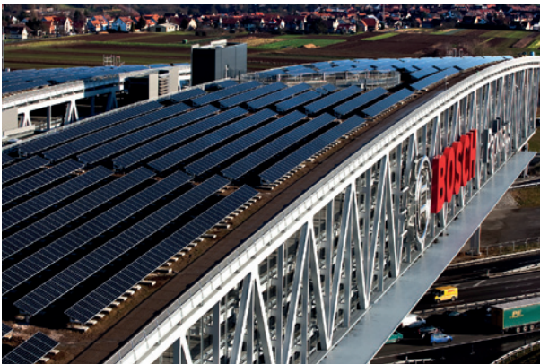
Bild 6.24 Solare Energieerzeugung auf dem Messeparkhaus in Stuttgart [Bildquelle: Bosch]
