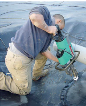
Bild 4.131 Beispiele für das Extrusionsschweißen [Bildquellen: Leister und Schatzgarten Landschaftsbau]
